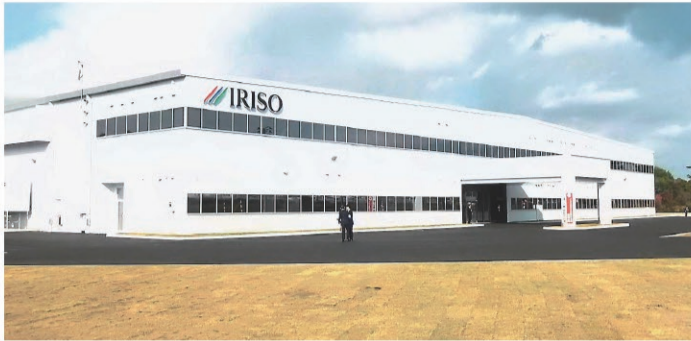
国内では2番目の工場となる秋田工場の外観
